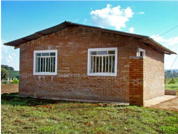
Fig. 05: Parede externa crua.
