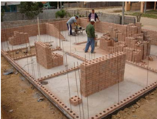
Fig. 04: levantamento das paredes.
